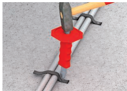
Rohrfixierung mit abbrechbarem FixPin und Gewebeband
