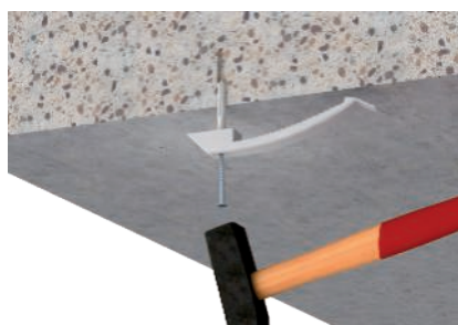
Einschlagen in die Decke
