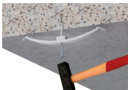
Einschlagen in die Decke
