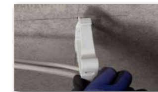
2 Einfaches Aufstecken des Systemdübels (CMS 5, 6, 7 oder 8). Sammelhalter einstecken.
