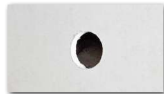
1 Bohren des mittleren Lochs.
