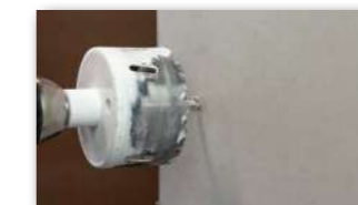
5 In vorgegebenes Loch auf der gegenüberliegenden Seite mit Zentrierbohrer der Fräskrone bohren; Dosenloch senken.
