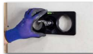
2 Präzises Ausrichten mit der integrierten Wasserwaage und Befestigen der Bohr-schablone mit dem Spanner.
