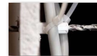
4 Ø 5 mm Loch bohren: Bohrer wird durch den f-fix geführt und durch die gegenüberliegende Wandseite gebohrt.
