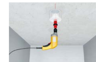
Mit einem Lochschneider wird die individuelle Öffnung ausgebohrt ...
