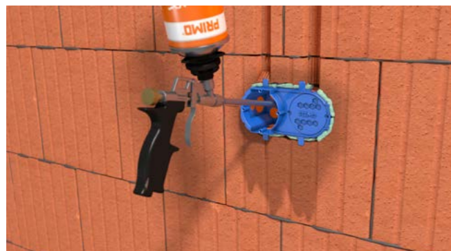
Thermodosen einschäumen.
