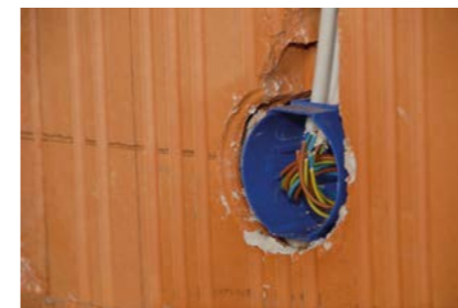
Unterteil bündig setzen. Elektrokabel oder Rohre einbringen.
