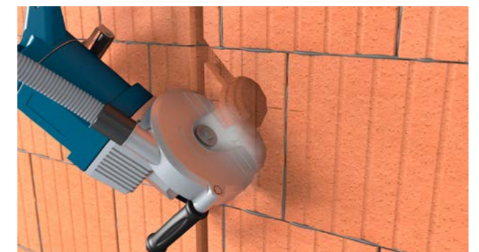
Variante 2: Schlitz bis in das Dosenloch fräsen.
