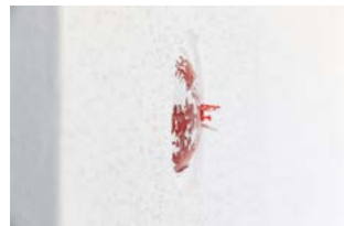
Nach dem Verputzen steht der Putzdeckel hervor.
