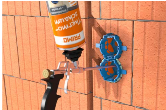
Thermodosen einschäumen.
