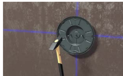
Frontteil auf der Schalung mit Nägeln befestigen. Die integrierte Nagelfixierung ermöglicht eine einfache Montage.
