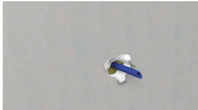
... mit Hammer Loch schlagen. Dorn durchstoßen, dieser dient als Zentrierung.
