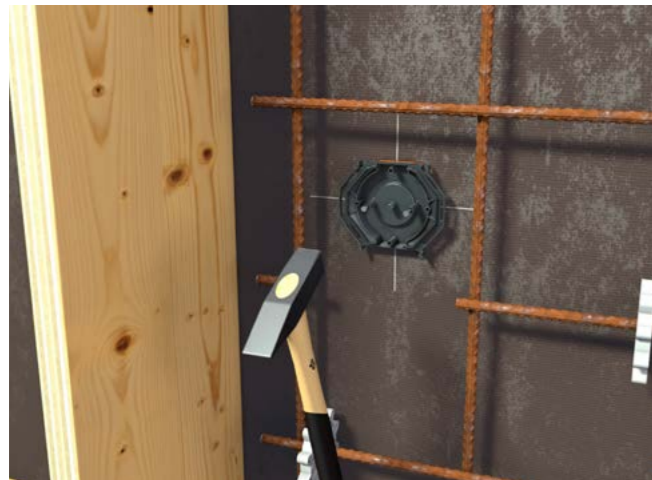
Deckel auf der Schalung mit Nägeln befestigen. Die integrierte Nagelfixierung im Deckel ermöglicht eine einfache Montage.
