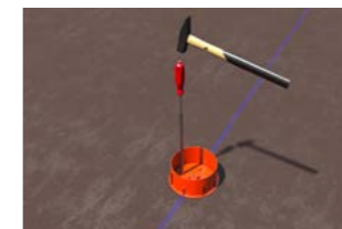
Lüftungshülse auf die Schalung nageln.
