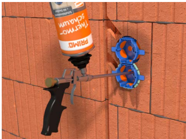
Thermodosen einschäumen.
