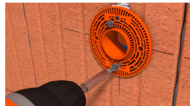
Schrauben finden im Geräteträger eine passende Öffnung und Halt.
