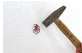
Mit dem Hammer leicht auf den Putzdeckel schlagen.
