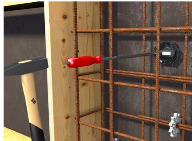
Wurde die zweite Bewehrung bereits angebracht, kann der Deckel mit dem Nagler (P752) positioniert und aufgenagelt werden.
