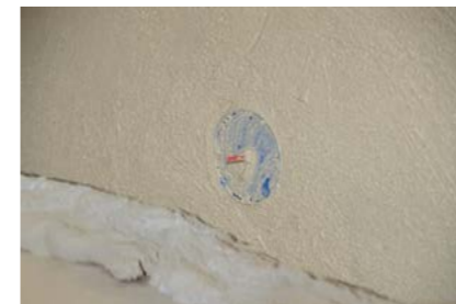
Der Putzer drückt das Dosenoberteil putzbündig.
