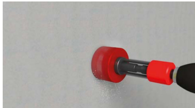
Mit Dosenfräser Loch ausfräsen.
