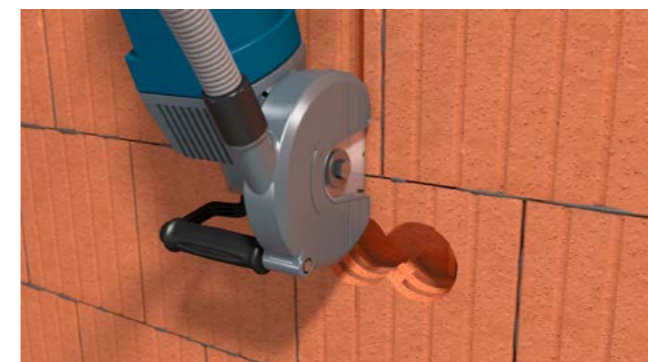
Variante 1: Schlitz bis kurz vor Dosenloch fräsen.
