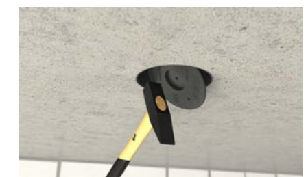
Nach dem Entschalen das Frontteil mit einem Hammerschlag öffnen.
