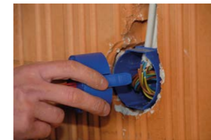
Dosendeckel einrasten lassen.
