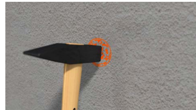
Deckel mit Putzfedern vorsichtig mit Hammer einschlagen.
