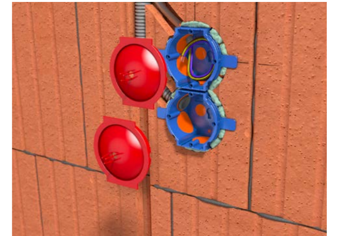
Putzdeckel aufsetzen.
