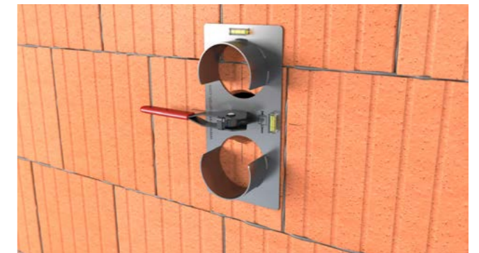
Bohrschablone ins vorhandene Loch einsetzen und ausrichten.
