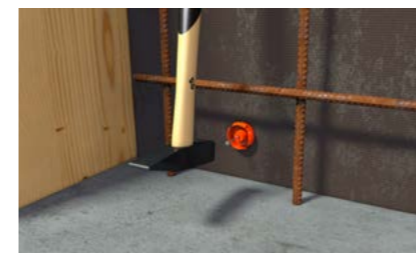
Frontteil auf die Schalung nageln.
