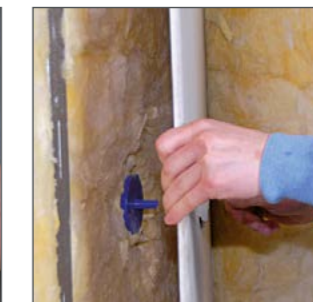
Der Trockenbauer schlägt mit dem Hammer ein Loch aus und lässt den Mitteldorn durchstehen.
