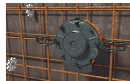
Flügel mit Draht an der Stahlarmierung befestigen.
