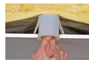
Schutzkappe in Bohrloch einschieben.
