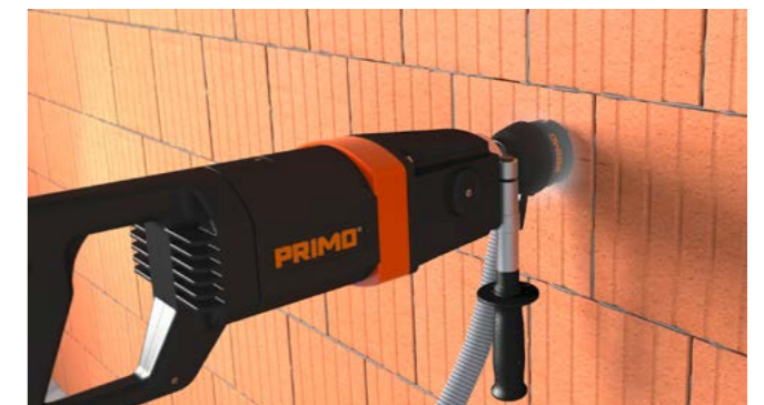
Erste Dose anzeichnen und mit Ø 82 mm Schnellläufer ausbohren.
