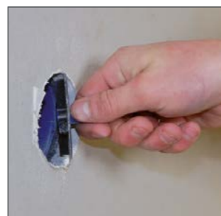
Leichtes Rausnehmen des durchfrästen Bohrdeckels.
