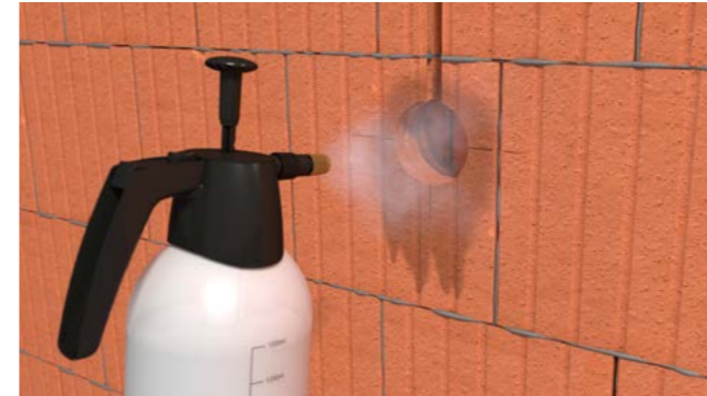
Bohrung anfeuchten, Schaum quillt dadurch noch besser auf.
