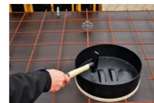
Im Ortbeton auf Schalung nageln oder im Betonfertigteilwerk auf den Schaltisch kleben.
