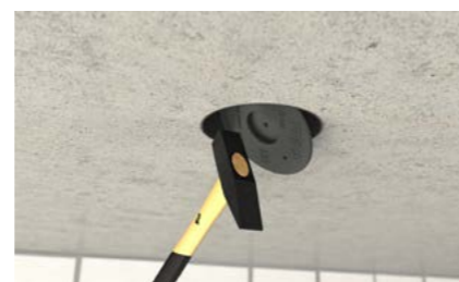
Nach dem Entschalen das Frontteil mit einem Hammerschlag öffnen.
