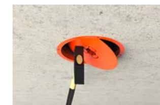
Lüftungshülse von unten mit Hammer einschlagen.
