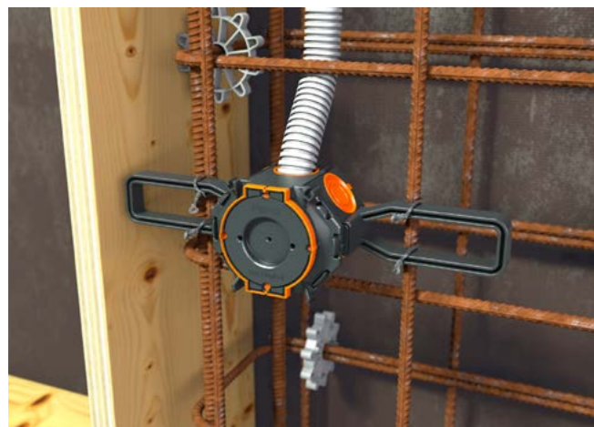
Flügel mit Draht an der Stahlarmierung befestigen.
