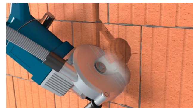
Schlitz bis in das Dosenloch fräsen.
