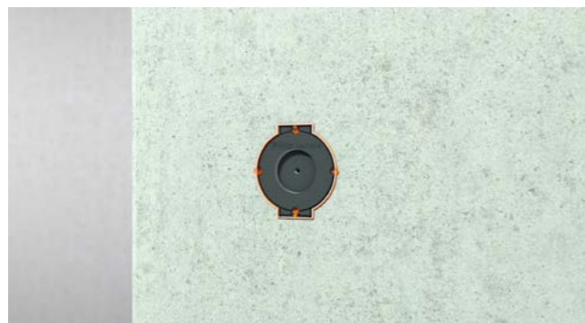
Die Membrandichtlippe verhindert das Einlaufen von Betonschleier und sorgt für einen sauberen Abschluss. Ideal für Sichtbeton geeignet.
