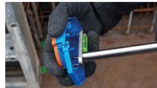
Deckel mithilfe 60 mm Aufnahmestifte aufnehmen.
