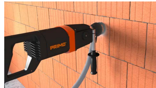
Erste Dose anzeichnen und mit Ø 82 mm Bohrkronen ausbohren.
