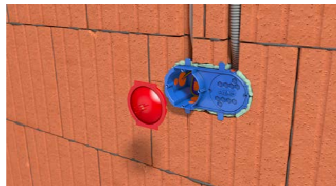
Putzdeckel aufsetzen.
