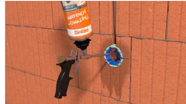
Dose setzen und einschäumen.
