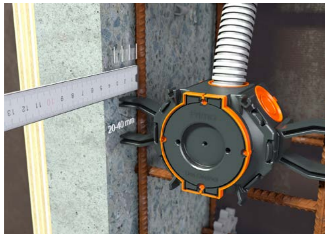
Die Flügel sind beidseitig aufsteckbar und eignen sich für Betonüberdeckungen von 20 – 40 mm ...
