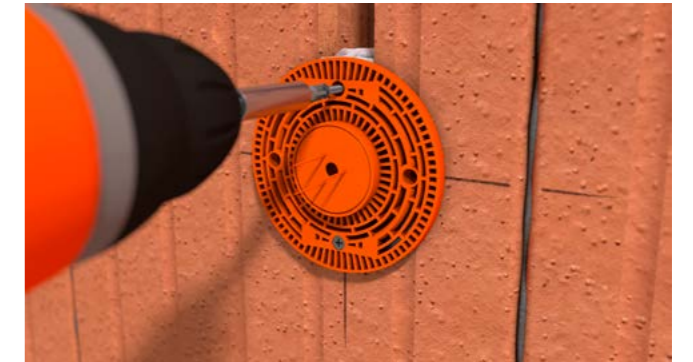
Geräteträger aufstecken und mit 2 Schrauben befestigen.
