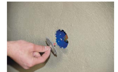
Putzhaut entfernen – fertig!
