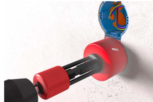
... oder mit einer Bohrkrona aufgebohrt werden.
