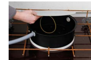
Rohre/Kabel einführen und stabile Blechplatte mit Kabelbinder befestigen.
