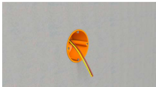
Hohlwanddose montieren und Einbaugerät/Steckdose installieren.
