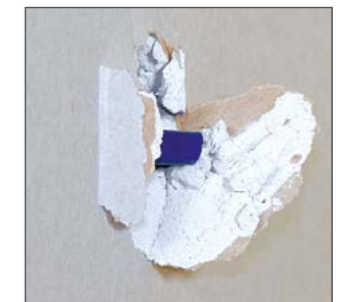
Der herausragende Mitteldorn dient als Zentrierung für die Ø 68 mm Bohrkronen.
