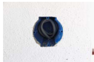
25 Sekunden für 5 Dosen ausbohren und Deckel entfernen.
