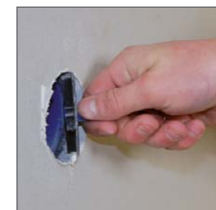
Leichtes Rausnehmen des durchfrästen Bohrdeckels.
