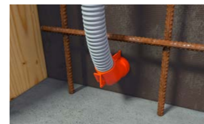
Krümmen schließen und auf das Frontteil stecken.
