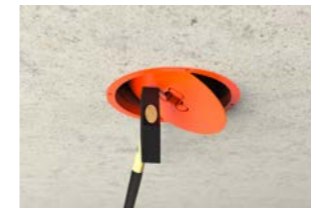
Lüftungshülse von unten mit Hammer einschlagen.
