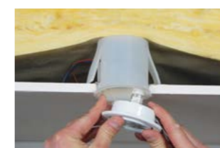
Strahler montieren.
