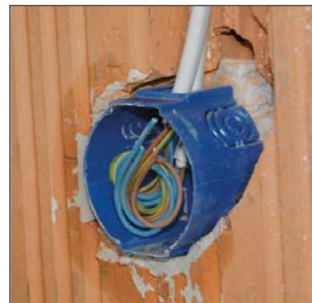
Dosenunterteil setzen ...
